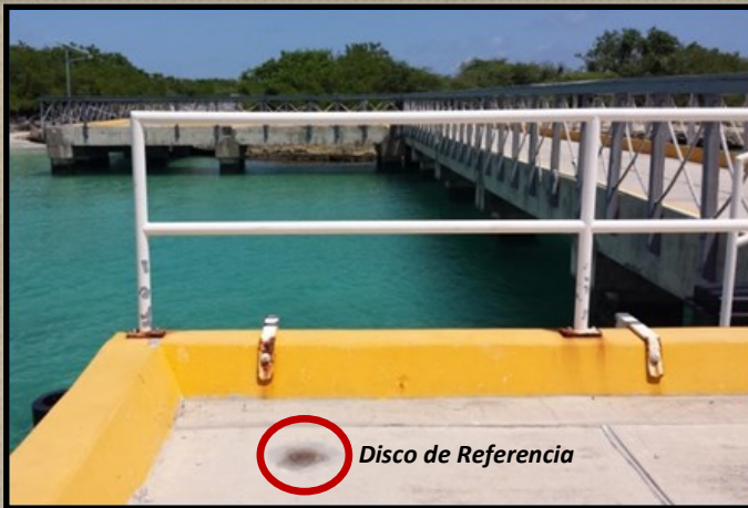
Figura 26: Vista de un disco de referencia en el muelle de la Isla Caja de Muertos. (RSPR-UPRM)
